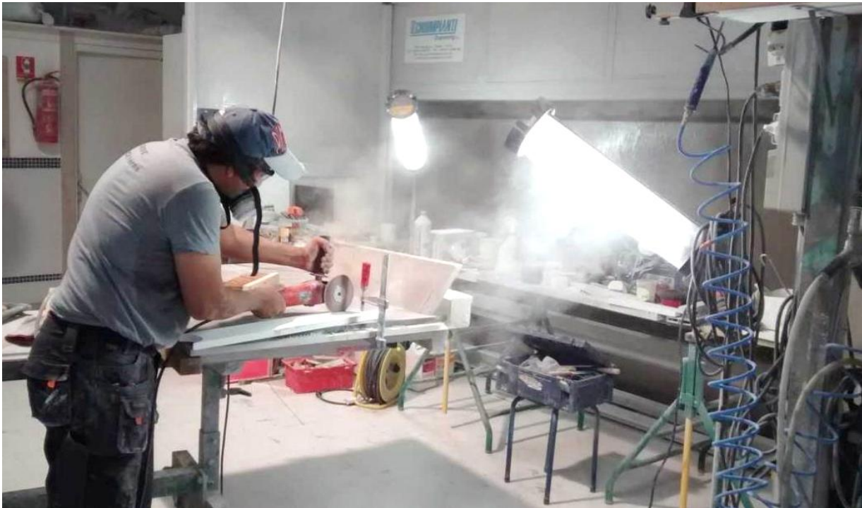
Façonnage d'un rebord de fenêtre en quartz à l'aide d'une disqueuse 125
